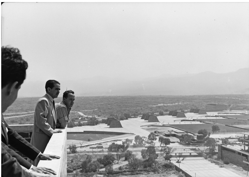
Supervisión de las obras durante la construcción de la Ciudad Universitaria. Fuente: IISUE.
